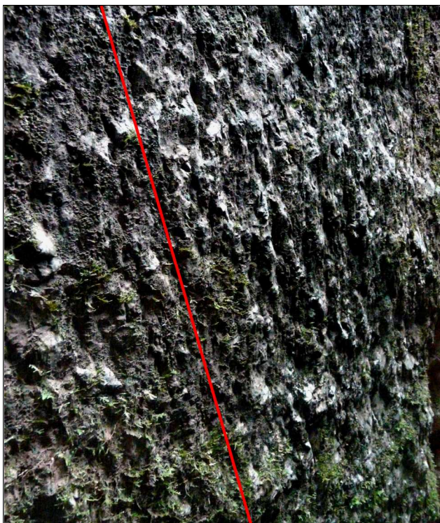
Fig. 10 : Eموssées par le temps, corrodées par une végétation acide, les traces de pointerolle ne sont pas toujours évidentes. Nous avons fait ressortir leur direction par un trait rouge.
