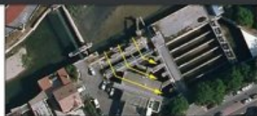
Le barrage envoie l'Huveaune dans les bacs de dégrillage, d'où elle rejoint l'émissaire 2 vers Cortiou. (Géoportail)
