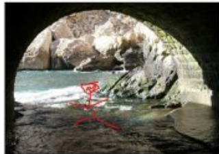
En bas : deux des trois sorties annexes qui permettent d'évacuer les crues.
